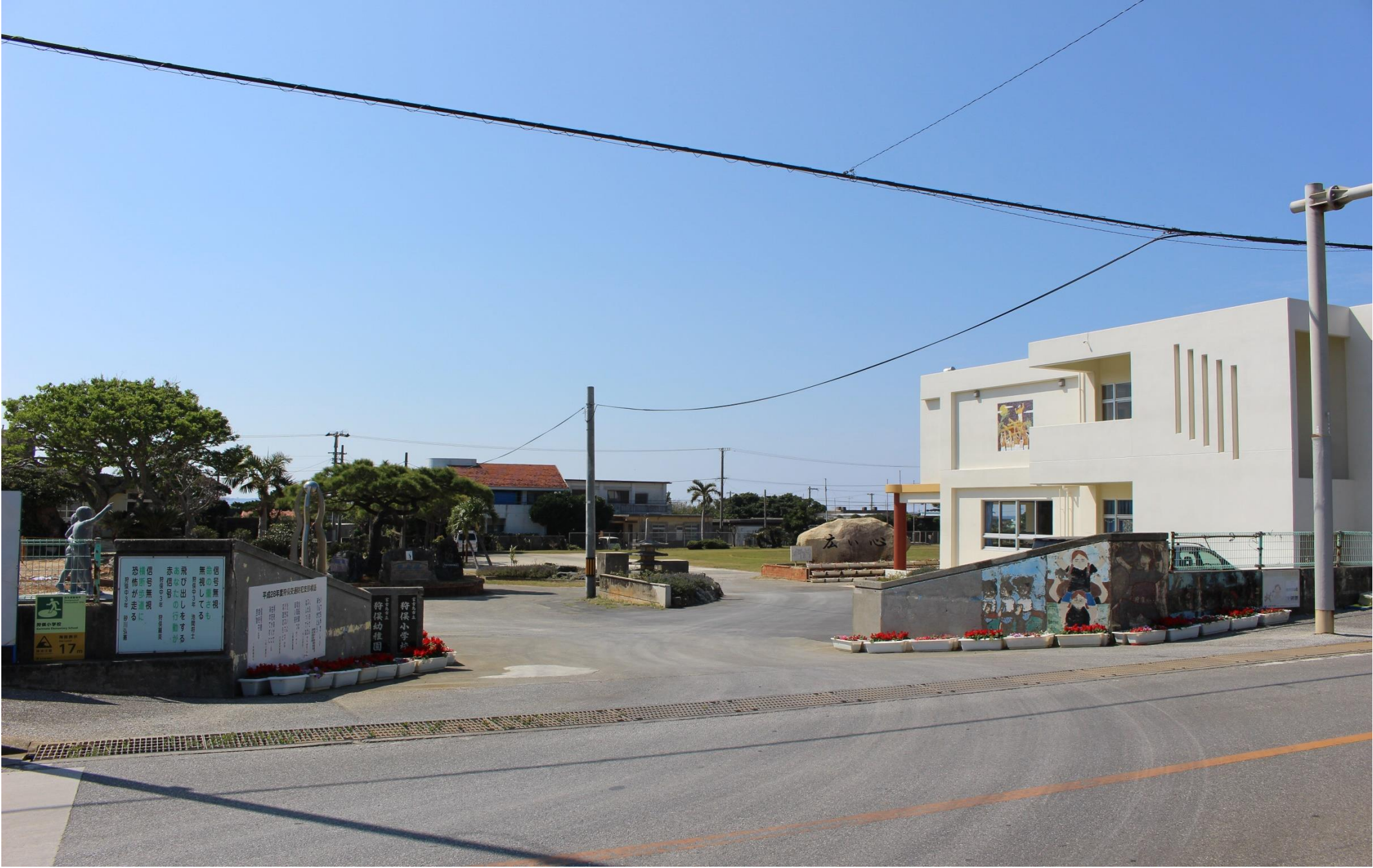
狩俣小学校 写真
