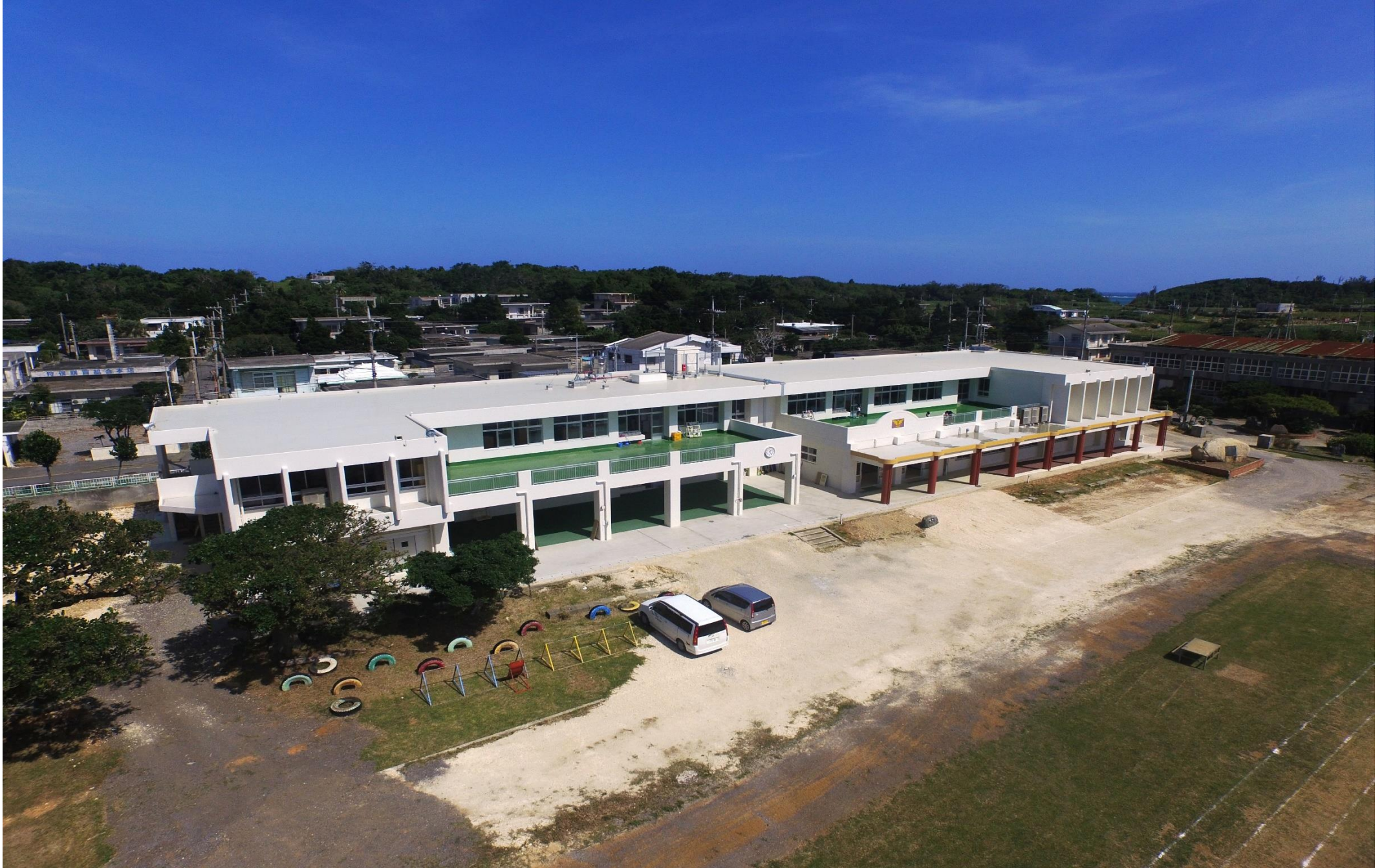
狩俣小学校 写真
